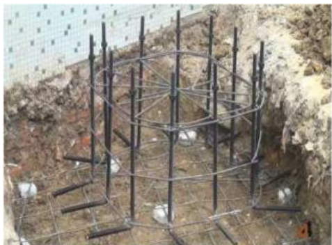
第一步：用钢筋+水泥先做混凝土地基。 Step 1: Make concrete foundation with steel and cement
