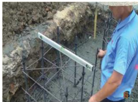
第一步：用钢筋+水泥先做混凝土地基。 Step 1: Make concrete foundation with steel and cement
