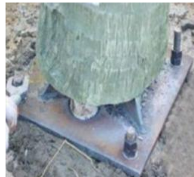
第二步：把树立起来，上螺丝固定。 Step2: Set it up and fix it with screws.
