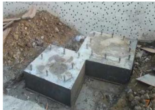
第一步：用钢筋+水泥先做混凝土地基。 Step 1: Make concrete foundation with steel and cement
