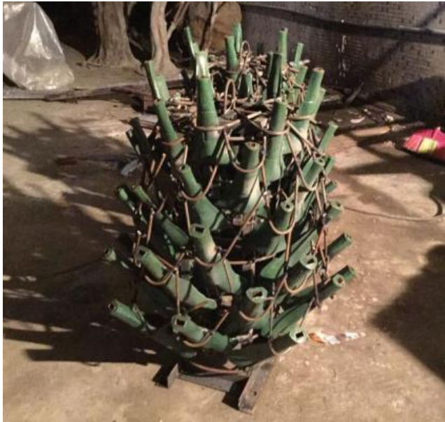
内部结构 Interior structure
